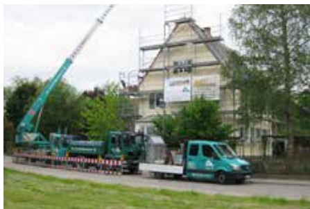
Nach der Dach- und Fassadensanierung können die Kinder wieder uneingeschränkt draußen spielen.
