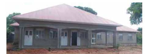
Das Pfarrhaus ist noch eine Baustelle.
