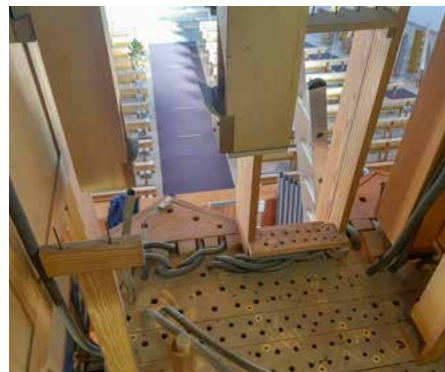
Gut einen Monat lang glich die Orgelempore einer Baustelle.
