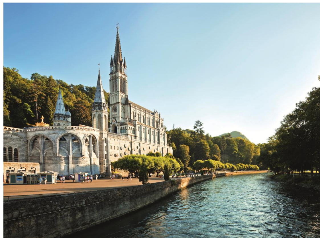
Seitenansicht der übereinanderliegenden Basiliken
